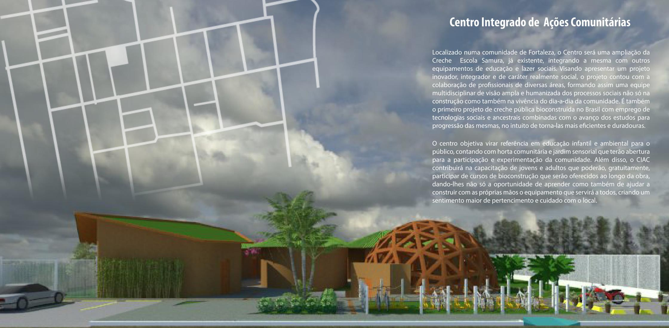
A responsabilidade ambiental é mais uma marca forte neste projeto, que será contruído com terra crua aplicando diversas técnicas como taipa de mão, tijolos de adobe fabricados no canteiro de obras, hiperadobe, etc., utilizando em grande parte a terra retirada da própria escavação para fundações e equipamentos hidrossanitários.
